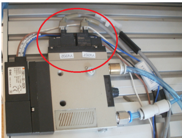
Obr. 6.8 Dva tlakové snímače na 4. poste
