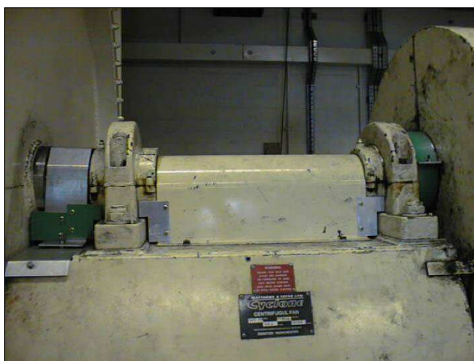
Obr. 35 Ložisko [18]
