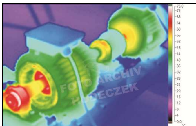
Obr. 35 Poškozené ložisko a špatné ustavení stroje [2]
