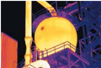
Inspekce žáruvzdorné izolace na petrochemickém reaktoru
