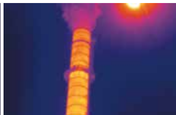
Kontrola žáruvzdorného materiálu na komínu pece
